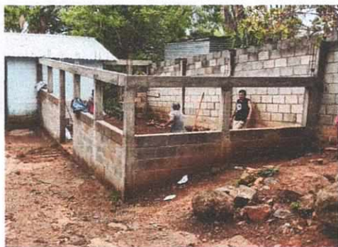
Foto 3: Se terminara de repara la cocina pues las condiciones en las que se cocinan los alimentos no es la adecuada
