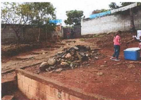
Foto 1: Se necesita fundir una rampa para acceso de los estudiantes y evitar el peligro de una caída por las personas que ingresan al establecimiento.
