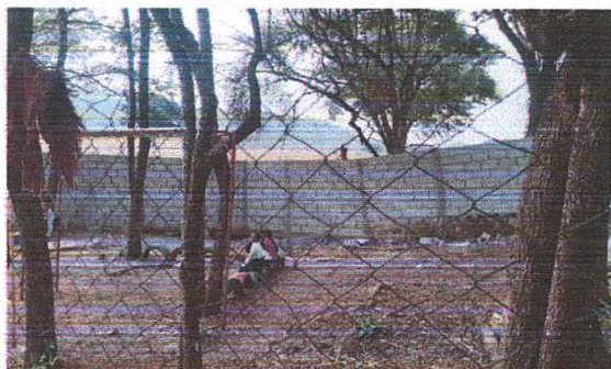
Foto 1: Muro perimetral terminado
