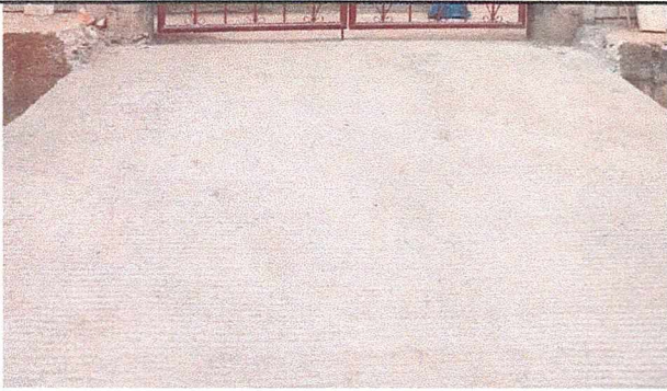
Foto 3: Rampa de ingreso al establecimiento.
