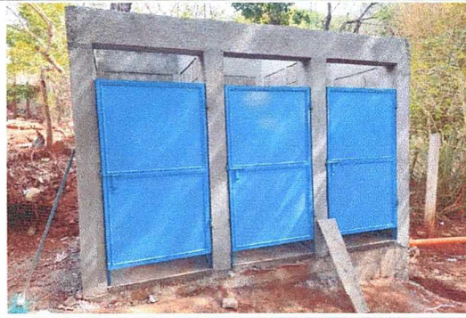
Foto 4: Levantado de paredes servicios sanitarios
