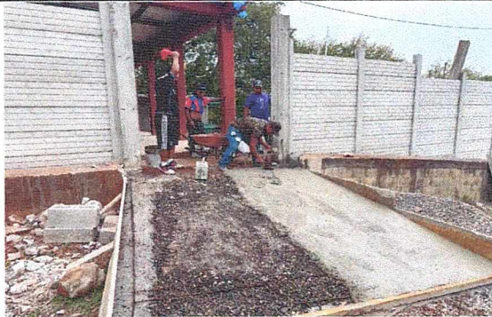
Foto 3: Mejoramiento ingreso al establecimiento.
