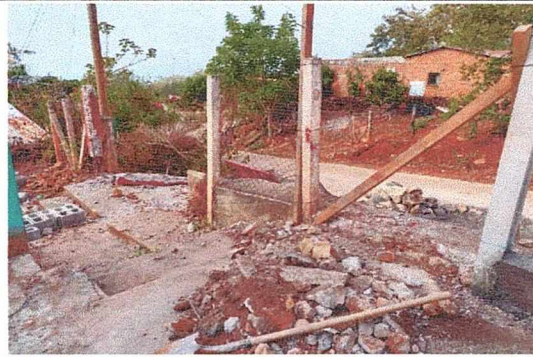
Foto 2: Demolição de columnas para colocar nuevo portón.
