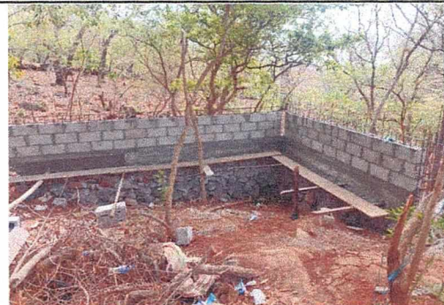
Foto 6: levantado de muro perimetral.
