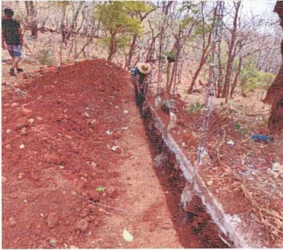
Foto 1: Elavoración Muro Perimetral.
