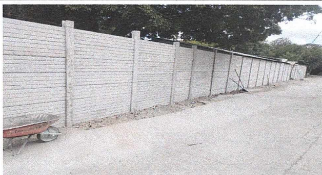
Foto 1: Finalización de muro prefabricado en colindancia de Escuela.
