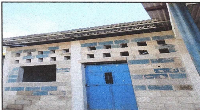
Foto 2: Finalización de la cocina
