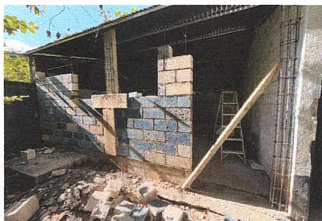
Foto 5: Levantado de muro de block para cerramiento de espacio de aula.
