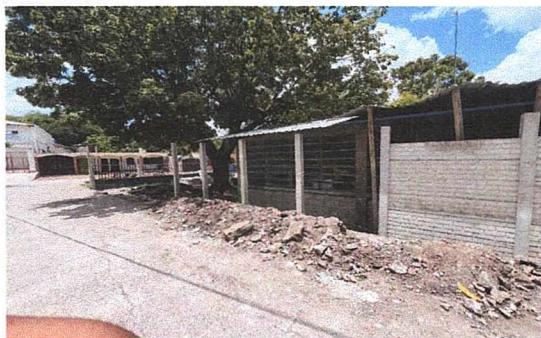
Foto1: Avance de levantado de muro prefabricado en colindancia de Escuela.
