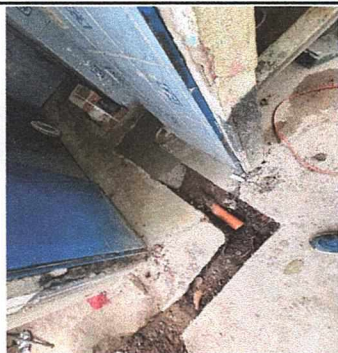
Foto 3: Instalacion de tubería para habilitacion de servicio sanitario en modulo de varones
