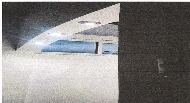
MEJORAMIENTO DE LA INSTALACION ELECTRICA
