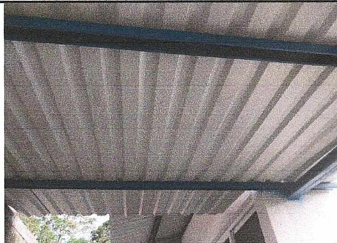
Foto 6: Area de pilas, cambio de techo concluido
