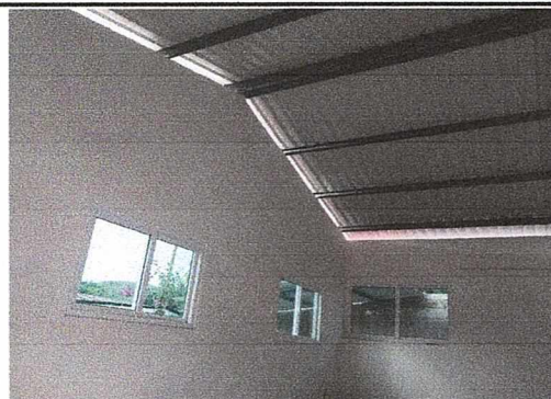
Foto 4: FINALIZACION DEL TECHO DE LA COCINA Y COMEDOR ESCOLAR
