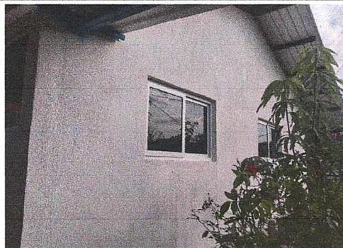
Foto 2: FINALIZACION DE VENTANAS PARA EL AREA DE COCINA
