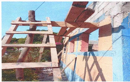
RECONSTRUCCION DE VENTANAS
