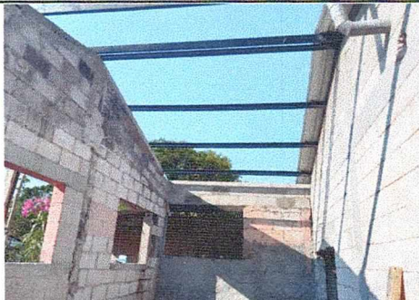
RECONSTRUCCION DE AREA DE PILAS,
