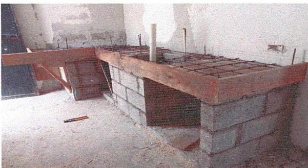
RECONSTRUCCION DE INSTALACIONES DE COCINA
