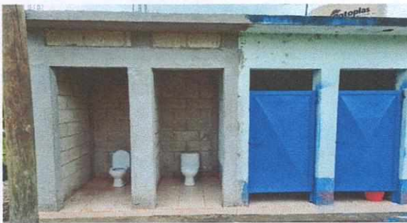
Foto 5: Pendiente de terminar baños con sus pueras
