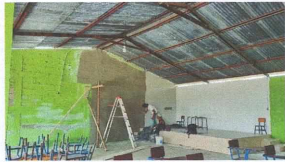
Foto 4: pendiente terminar el escenario falta repello
