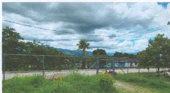
Foto 1: Terminado el arreglo de la malla con el tubo galvanizado en todo el perímetro de la escuela.
