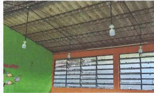
Foto 2: Terminada el cableado eléctrico de todo el establecimiento.
