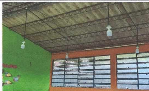
Foto 2: Terminado el cableado eléctrico de todo el establecimiento.
