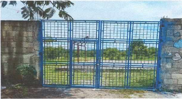
Foto 3: Porton terminado pintado y reforzado
