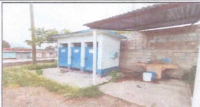
Foto1: Ampliación y remosion en servicios de baños reparacion he instalacion de recipientes de servicio de agua reparacion de pila y drenajes.
