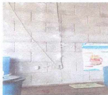
Foto 4: Reparacion del sistema electrico cableado cambio de tomacorrientes cambio de estacion principal de circuitos eléctricos.
