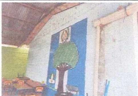
Foto 3: Reparación de sistema de canales agua llovediza y drenajes de evacuación y reparación de laminas dañadas en algunas aulas.
