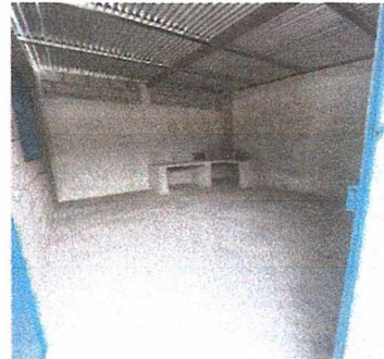
Foto 2: Interior terminado de la cocina, se modificó el pollo fuego para ampliar el área de cocina y que sea mas funcional.
