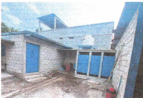
Foto 5: Conjunto de cocina, área de pila y módulo de servicios sanitarios.
