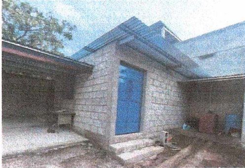
Foto1: Cocina ya terminada, con su puerta, su ventana, su techo y sus gradas.
