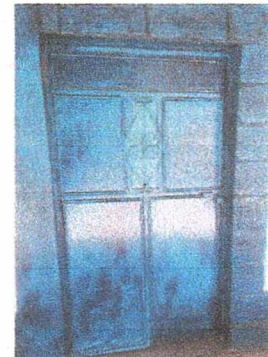
Foto 4: Reparación de chapas en puertas.
