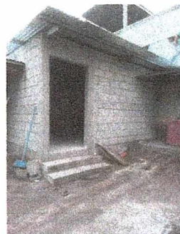
Foto 2: La cocina ya techada, adentro ya se trabajo el pollo fuego.
