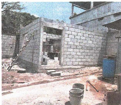
Foto1: Avance de levantado de muros en cocina.
