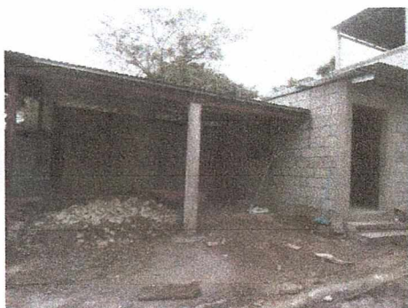
Foto 3: Techado de la ampliación del escenario.
