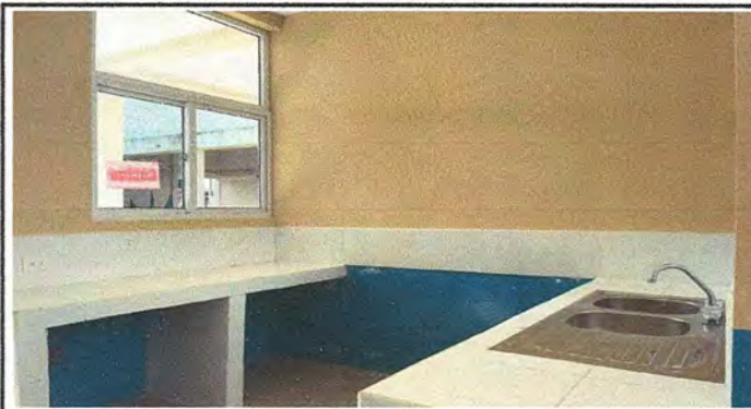
Foto 2: MEJORAMIENTO DE COCINA
