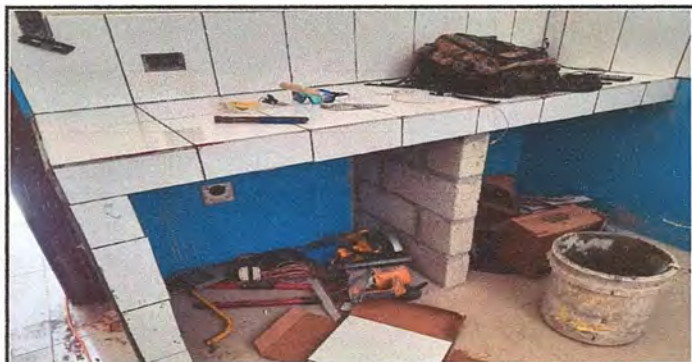
Foto 6: MEJORAMIENTO DE COCINA
