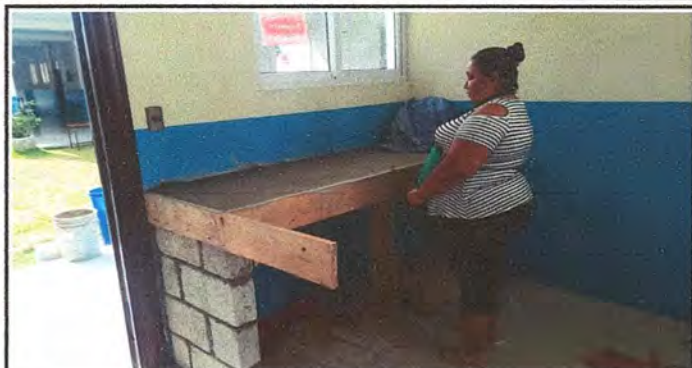
Foto 2: MEJORAMIENTO DE COCINA
