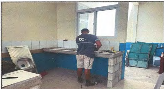
Foto 3: MEJORAMIENTO DE COCINA
