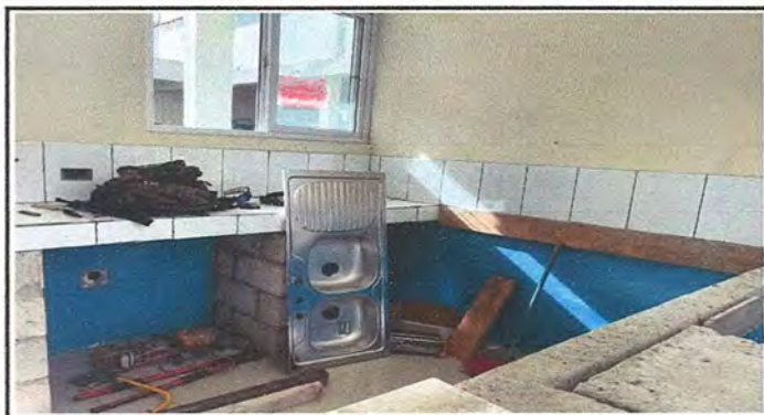
Foto 4: MEJORAMIENTO DE COCINA
