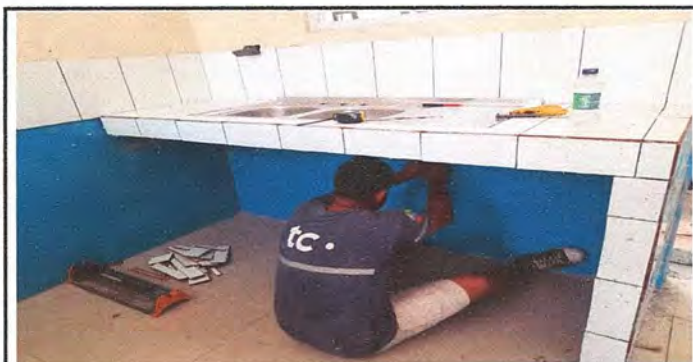
Foto 5: MEJORAMIENTO DE COCINA
