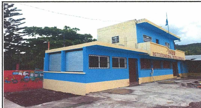
Foto 4: MEJORAMIENTO DE COCINA
