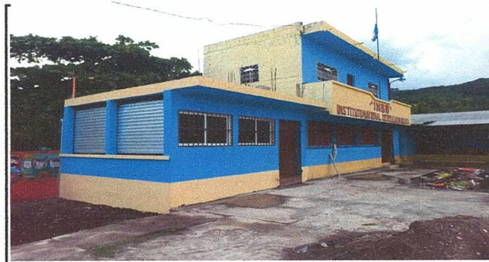
Foto 6: MEJORAMIENTO DE COCINA
