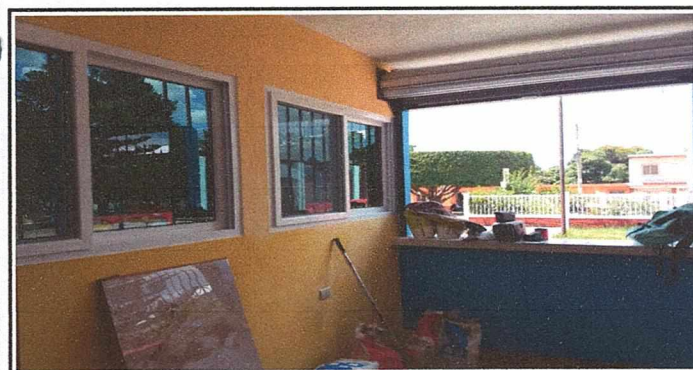
Foto 5: MEJORAMIENTO DE COCINA
