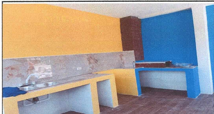
Foto1: MEJORAMIENTO DE COCINA
