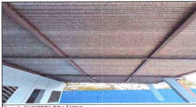
Foto 6: CUBIERTA DE LÁMINA
