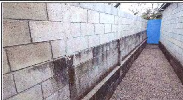
Foto 2: REPARACIÓN DE MUROS DE CONTENCIÓN
