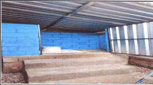
Foto 1: ESTRUCTURA DE TECHO
