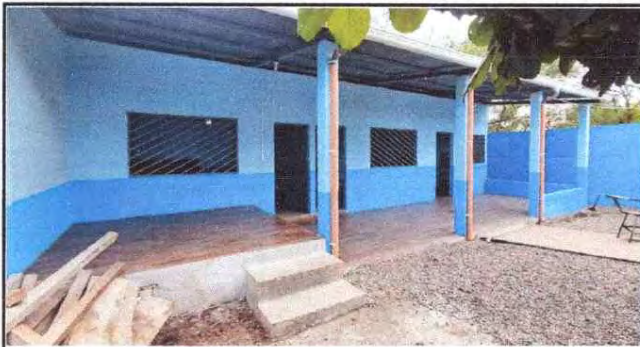
Foto 1: REPARACION DE PISO
