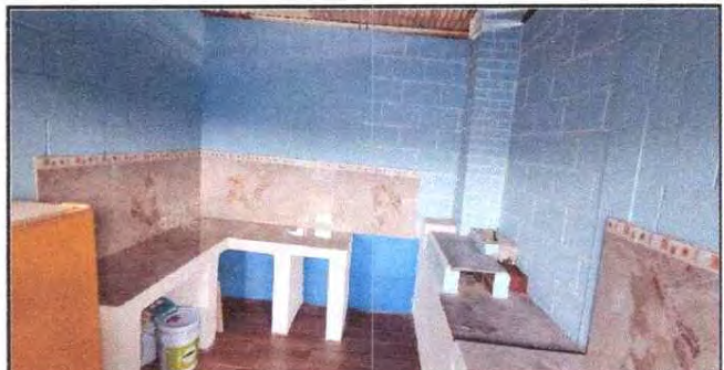
Foto 6: REPARACION DE COCINA
