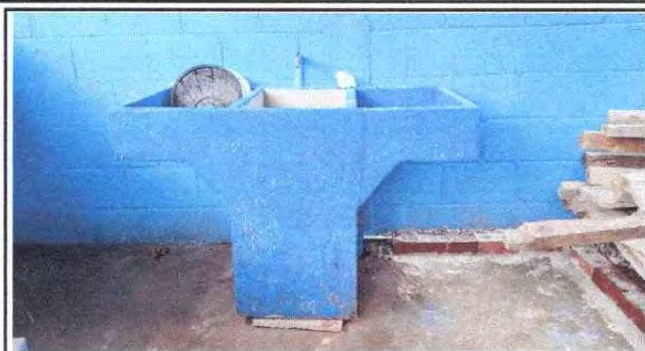
Foto 1: REPARACION DE PILA
