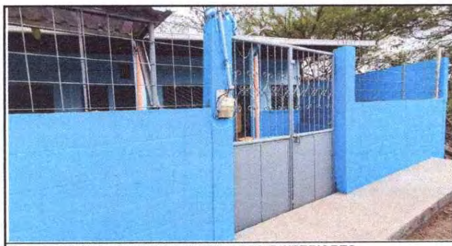
Foto 5: PINTURA DE MUROS EXTERIORES E INTERIORES
