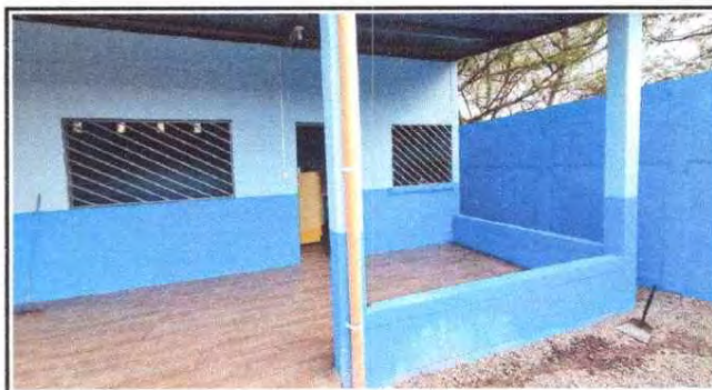
Foto 4: PINTURA DE MUROS EXTERIORES E INTERIORES
