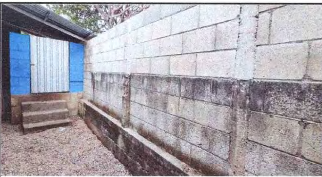
Foto 3: REPARACION DE MURO
