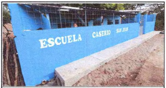
Foto 6: REPARACION DE MURO DE CONTENCIÓN
