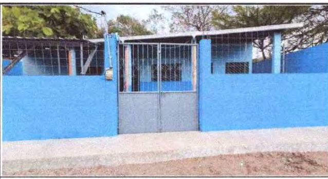
Foto 5: REPARACION DE PORTON
