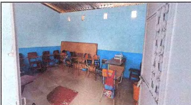
Foto 3: REPARACION DE PISO
