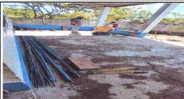
Foto 1: REPARACION DE PISO
