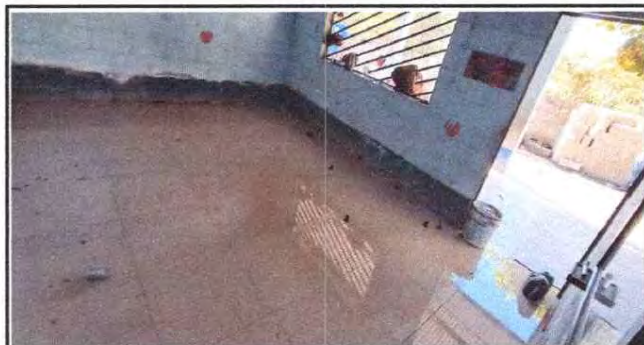
Foto 4: REPARACION DE PISO
