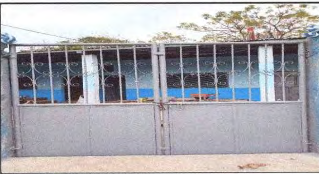
Foto 5: REPARACION DE PORTON
