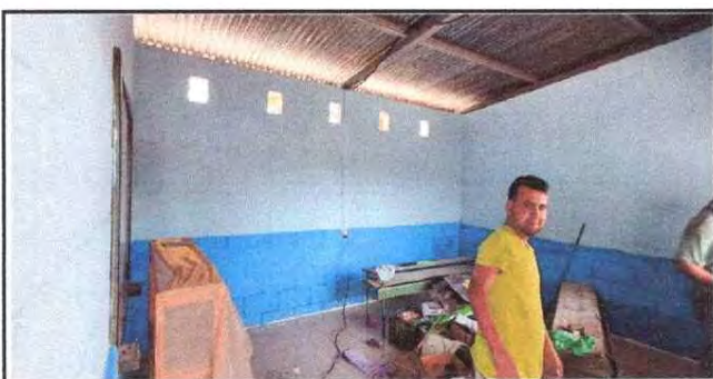
Foto 5: PINTURA DE MUROS EXTERIORES E INTERIORES
