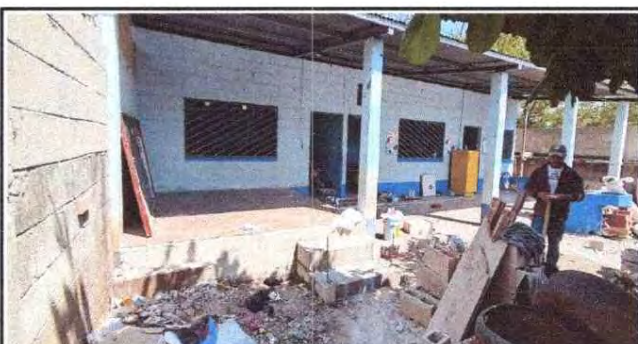
Foto 4: PINTURA DE MUROS EXTERIORES E INTERIORES
