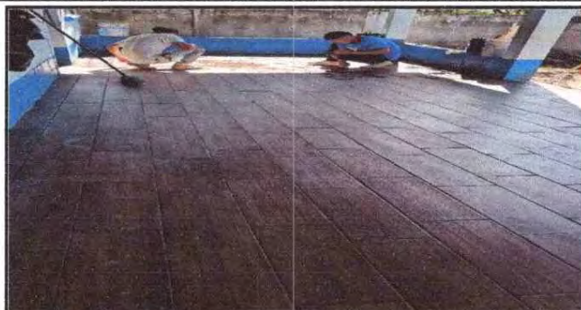
Foto 2: REPARACION DE PISO
