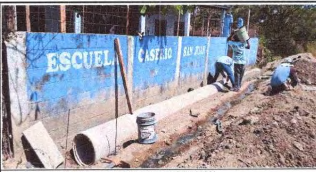
Foto 6: REPARACION DE MURO DE CONTENCIÓN
