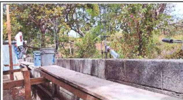
Foto 3: REPARACION DE MURO
