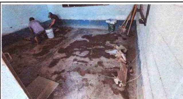
Foto 3: REPARACION DE PISO
