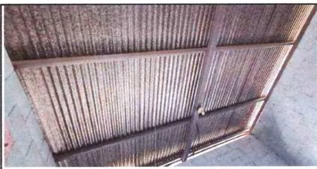
Foto 6: CUBIERTA DE LÁMINA
