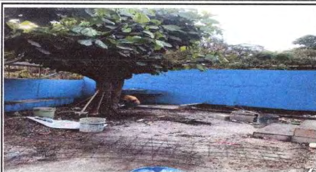
Foto 1: REPARACION DE PILA
