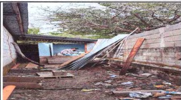
Foto 1: ESTRUCTURA DE TECHO
