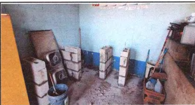
Foto 5: REPARACION DE COCINA
