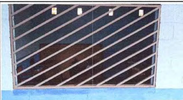
Foto 4: REPARACIÓN DE BALCONES
