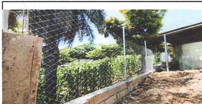
Foto 4: muro con malla
