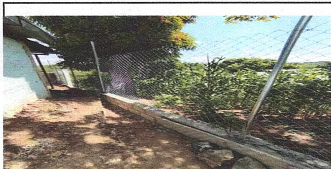
Foto 3: muro con malla
