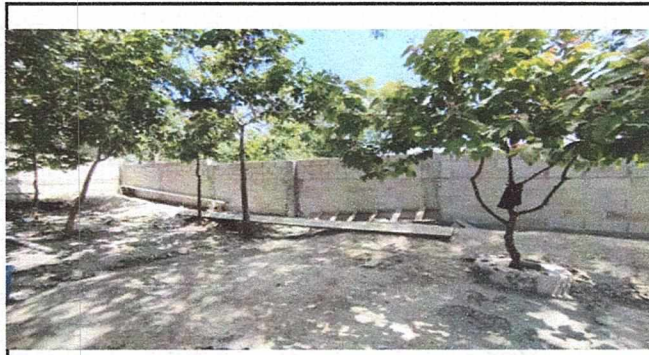
Foto 2: muro de mampostería
