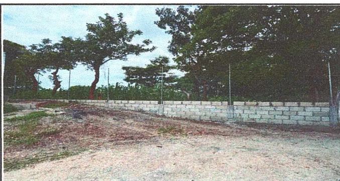
Foto 4: Avance del muro con malla
