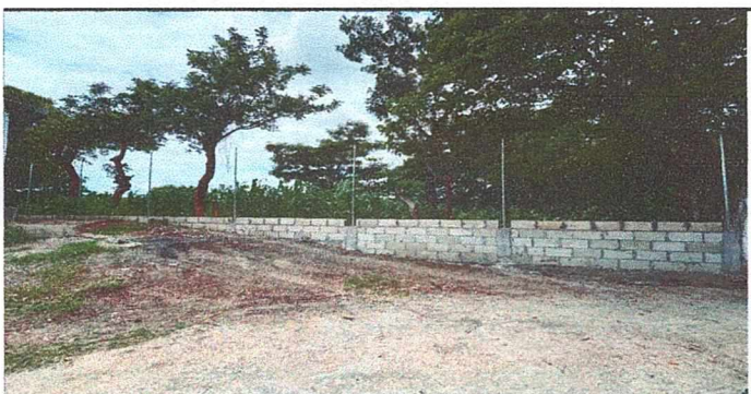
Foto 3: Avance de muro con malla
