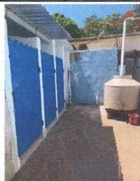
Foto 6: MANTENIMIENTO A ESTRUCTURA (LIJADO, CAMBIO DE TUBO , CEPILLADO, SUJECCIONES, APLICACIÓN DE PINTURA) EN PUERTAS
