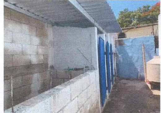
Foto 4: SUSTITUCIÓN DE TECHO CON ESTRUCTURA METÁLICA Y LÁMINA TROQUELADA, SUSTITUCIÓN DE BAÑOS Y SUSTITUCIÓN DE TORTA DE CONCRETO POR PISO CERAMICO EN SERVICIOS SANITARIOS
