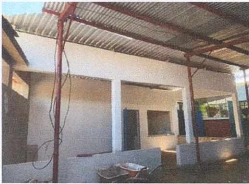
Foto 1: SUSTITUCIÓN TECHO, MEJORAMIENTO DE PAREDES, SUSTITUCIÓN DE ESTUFA RURAL, SUSTITUCIÓN DE PISO, MANTENIMIENTO DE PUERTA E INSTALACIÓN DE ESTRUCTURA DE METAL DE VENTANA EN AREA DE COCINA
