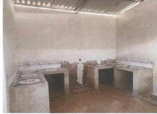
Foto 2: SUSTITUCIÓN TECHO, MEJORAMIENTO DE PAREDES, SUSTITUCIÓN DE ESTUFA RURAL, SUSTITUCIÓN DE PISO, MANTENIMIENTO DE PUERTA E INSTALACIÓN DE ESTRUCTURA DE METAL DE VENTANA EN AREA DE COCINA
