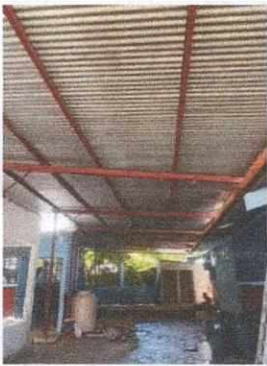
Foto 3: SUSTITUCIÓN TECHO CON ESTRUCTURA DE METAL POR LÁMINA TROQUELADA EN PATIO
