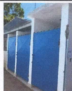
Foto 6: MANTENIMIENTO A ESTRUCTURA (LIJADO, CAMBIO DE TUBO , CEPILLADO, SUJECCIONES, APLICACIÓN DE PINTURA) EN PUERTAS
