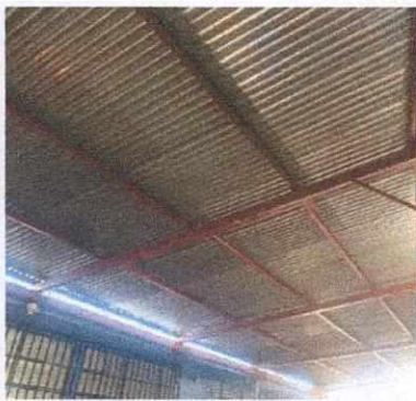
Foto 3: SUSTITUCIÓN TECHO CON ESTRUCTURA DE METAL POR LÁMINA TROQUELADA EN PATIO
