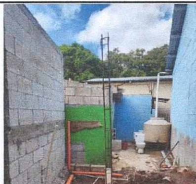
Foto 4: SUSTITUCIÓN DE TECHO CON ESTRUCTURA METÁLICA Y LÁMINA TROQUELADA, SUSTITUCIÓN DE BAÑOS Y SUSTITUCIÓN DE TORTA DE CONCRETO POR PISO CERAMICO EN SERVICIOS SANITARIOS
