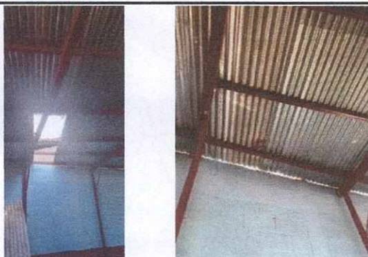
Foto 3: SUSTITUCIÓN TECHO CON ESTRUCTURA DE METAL POR LÁMINA TROQUELADA EN PATIO
