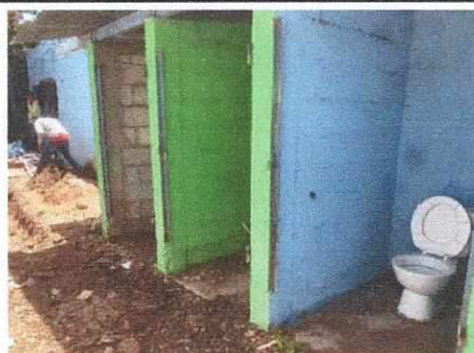
Foto 6: MANTENIMIENTO A ESTRUCTURA (LIJADO, CAMBIO DE TUBO , CEPILLADO, SUJECIONES, APLICACIÓN DE PINTURA) EN PUERTAS
