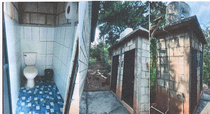
Foto 3: Sanitarios, se colocará piso y azulejo en baños, también un tinaco con su tubería para almacenamiento de agua y una torta por fuera, seguido de torta como encaminamiento hacia el sanitario.
