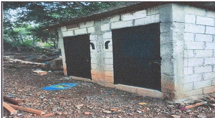
Foto 2: Puertas de lámina en los sanitarios, se colocarán puertas de metal en los 2 sanitarios.
