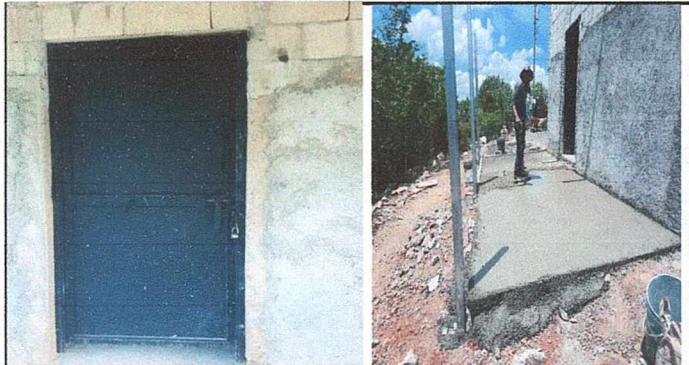
Foto 6: Puerta de lámina, tierra en parte saliente de cocina, se colocará una puerta de metal y se hará una torta afuera.
