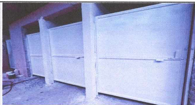
Foto 5: mejoramiento de baños
