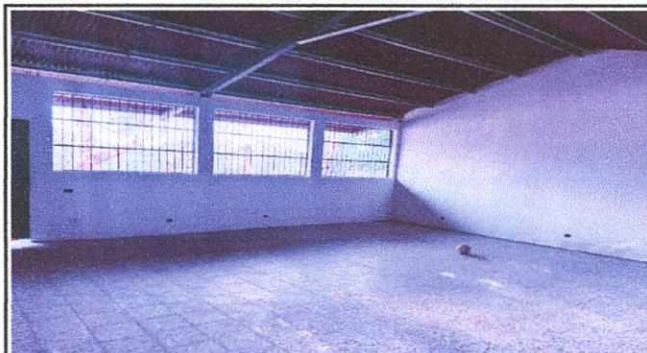
Foto 4: mejoramiento de ventanas y paredes del aula
