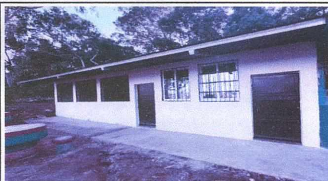
Foto 3: Mejoramiento de paredes y piso de aula
