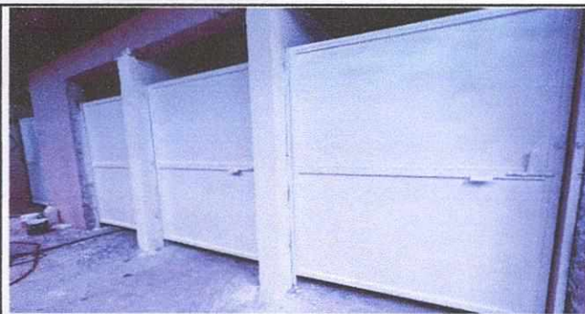
Foto 5: mejoramiento de baños
