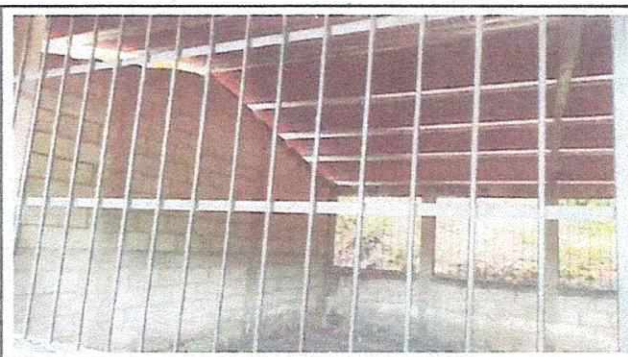
Foto 4: mejoramiento de ventanas y paredes del aula
