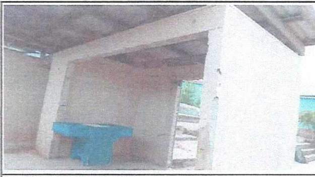
Foto 5: mejoramiento de baños
