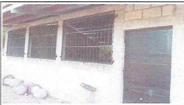
Foto 3: Mejoramiento de paredes y piso de aula
