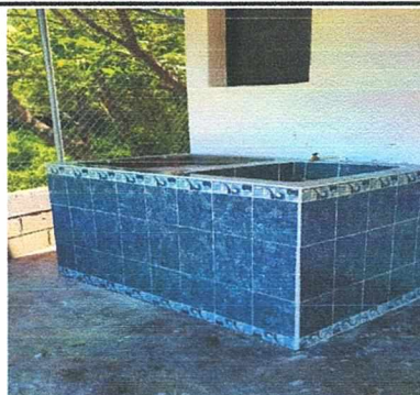
Foto 2: Sustitución de pila de concreto con azulejo
