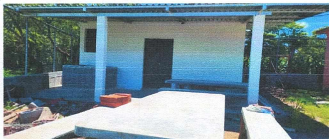
Foto 5: Colocación de mesas y bancas de concreto
