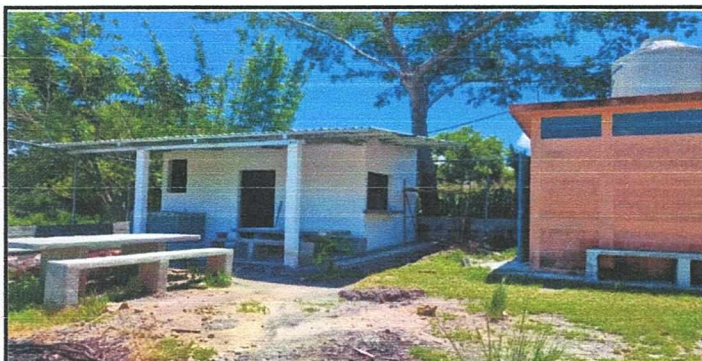
Foto 6: Mejoramiento de cocina finalizada con colocación de sistema eléctrico
