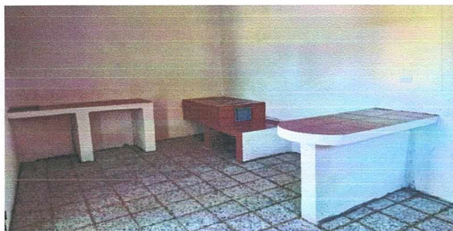
Foto 3: Colocación de dos mesas de concreto
