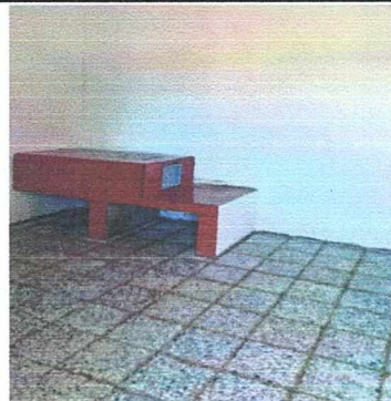
Foto 2: Colocación de piso de granito
