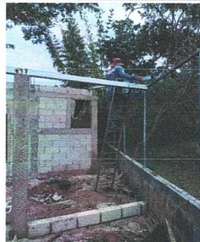
Foto 2: Instalación de techo con estructura metalica y lamina troquelada
