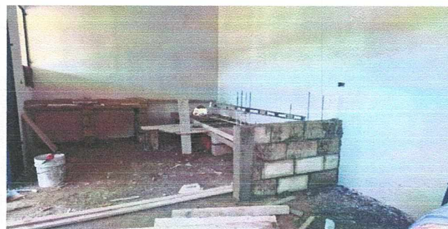
Foto 2: Mejoramiento de estufa rural con chimenea
