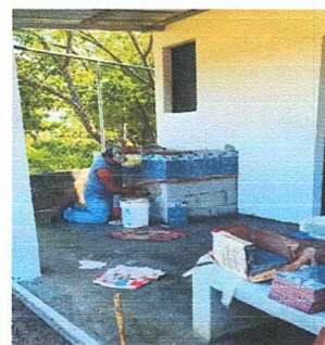
Foto 6: Colocación de plancha de concreto
