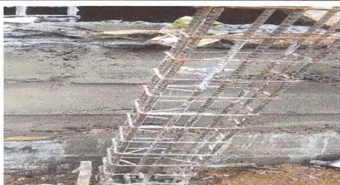
Foto 3: fundición de cimientos
