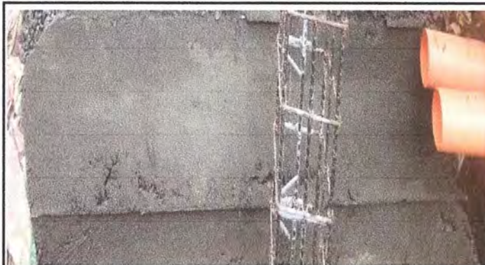
Foto 2: Fundición de cimientos terminada
