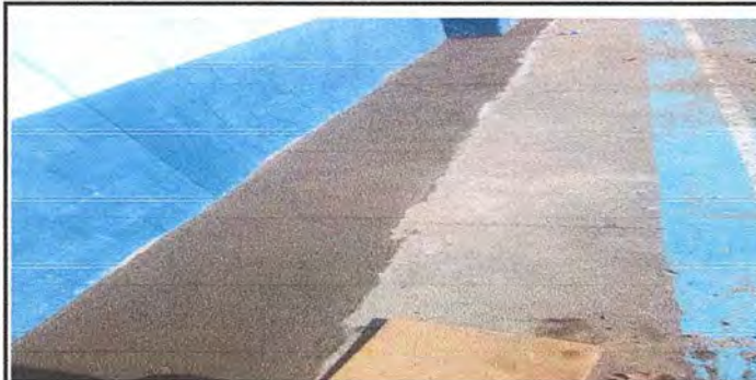
Foto 6: Fundición de finalización de cimientos.
