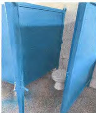
Foto 3: Puertas y divisiones instaladas
