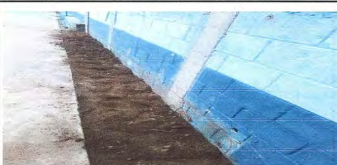
Foto 5: Ultima capa de tierra del cimiento
