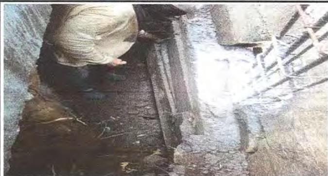
Foto1: Quintando la tabla de la fundición
