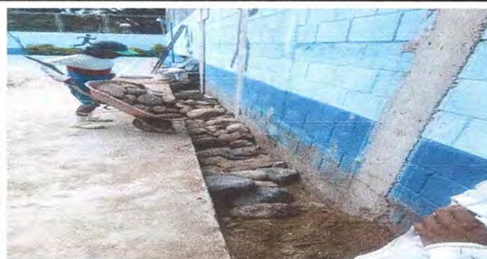
Foto 4: Llenando de piedra la parte socavada
