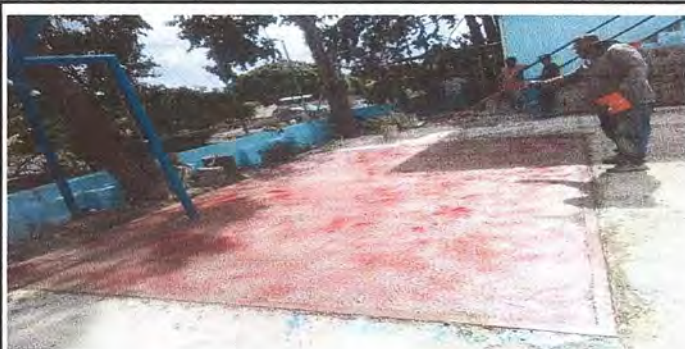
Foto 3: torta cancha poliderportiva
