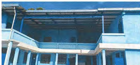
Foto 3: área del techo terminada
