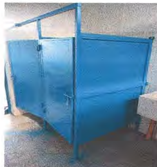
Foto 2: Puertas y divisiones instaladas
