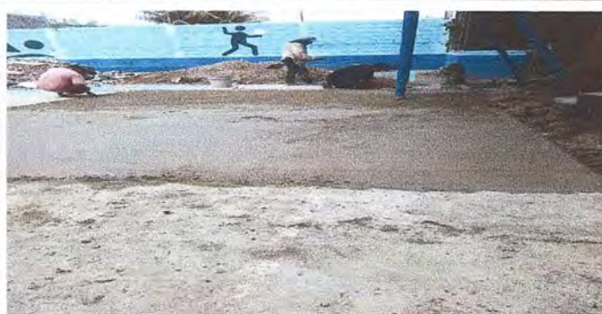
Foto 2: torta cancha poliderportiva
