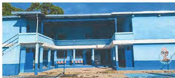
Foto 2: área del techo terminada
