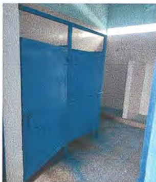
Foto 1: Puertas y divisiones instaladas
