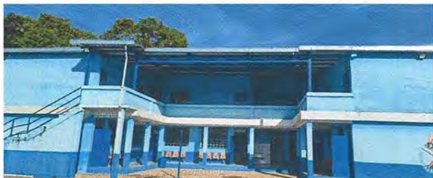
Foto 1: área del techo terminada
