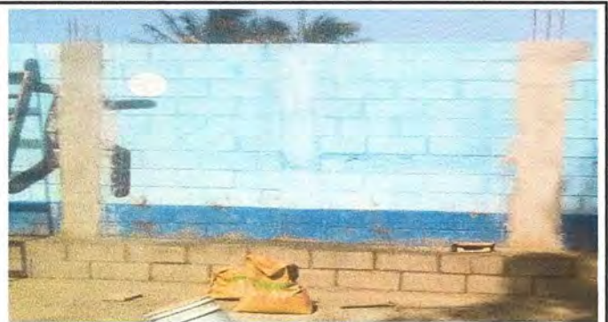
Foto 4: columnas de refuerzo muro perimetral
