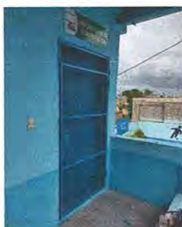
Foto 3: Instalación puerta reja
