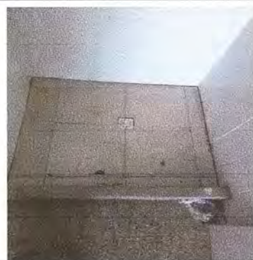
Foto 4: Instalación de piso antideslizante baños hombres y mujeres
