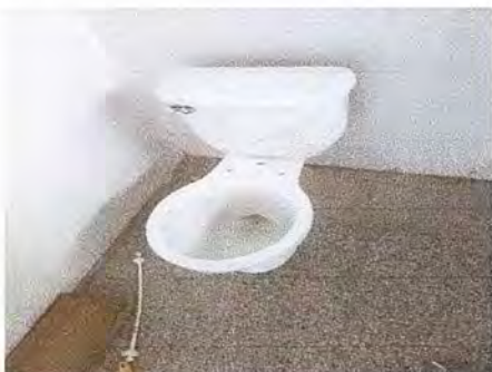
Foto 1: Instalación sanitarios baños damas
