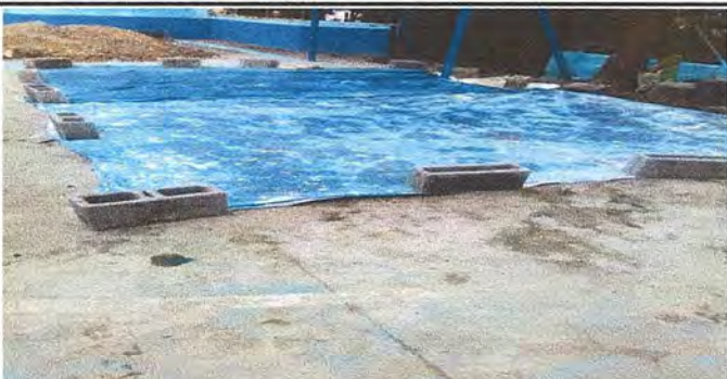
Foto 6: torta cancha poliderportiva
