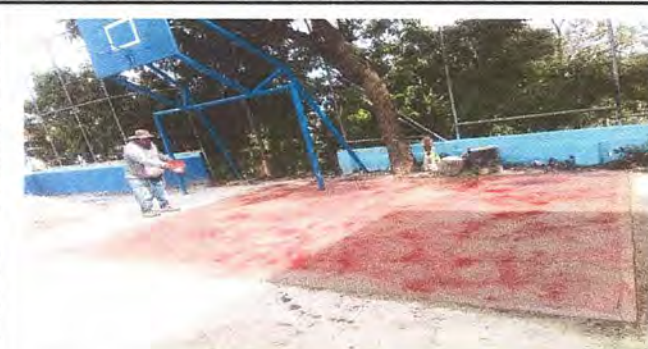
Foto 4: torta cancha poliderportiva
