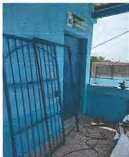
Foto1: Colocación balcón y puerta reja
