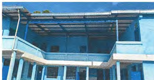
Foto 4: área del techo terminada
