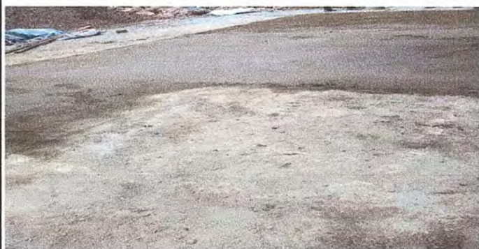
Foto 1: torta cancha poliderportiva
