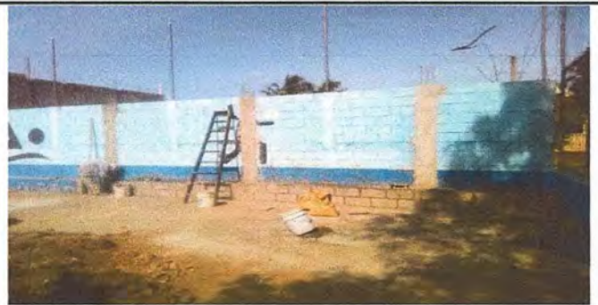
Foto 2: columnas de refuerzo muro perimetral
