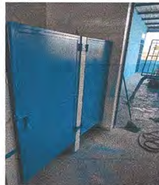
Foto 4: Puertas instaladas baños de hombres segundo nivel
