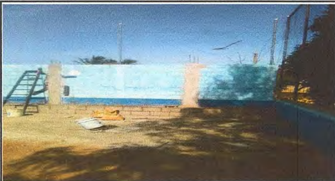
Foto 3: columnas de refuerzo muro perimetral
