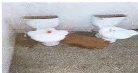
Foto 2: Instalación sanitarios baños damas
