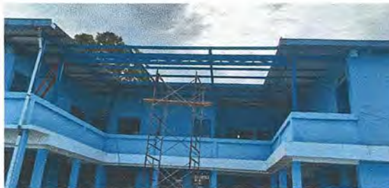
Foto 4: instalación de estructura para el techo
