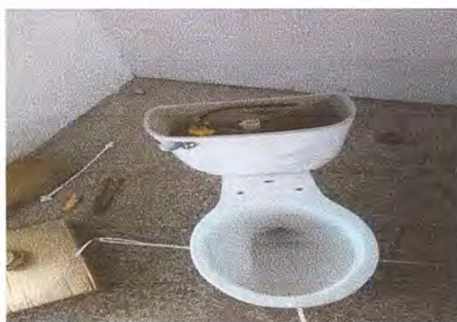
Foto 4: Iniciando a instalar sanitarios baños damas
