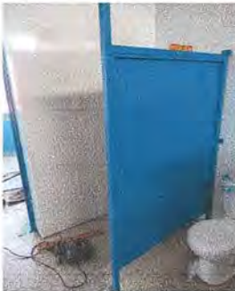
Foto 3: Instalando divisiones de baños damas segundo nivel
