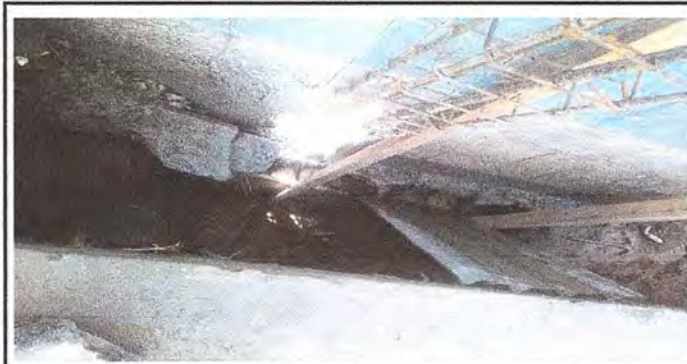
Foto 6: fundiendo segunda parte de cemento de piedra
