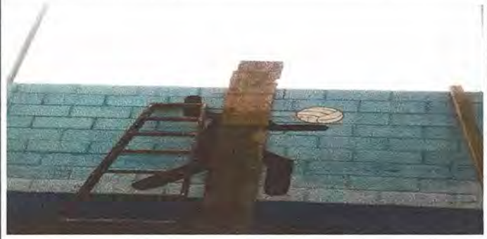
Foto 2: fundiendo columnas de refuerzo muro perimetral
