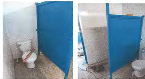
Foto 4: Instalando divisiones de baños damas segundo nivel
