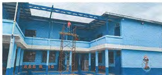
Foto 2: instalación de estructura para el techo
