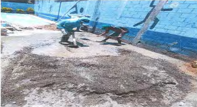
Foto 1: fundiendo columnas de refuerzo muro perimetral
