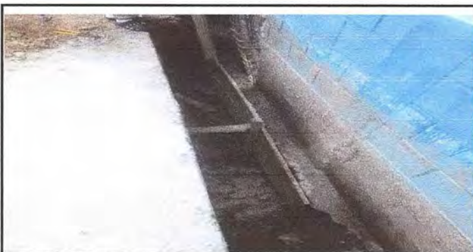
Foto 6: Fundición del cemento.
