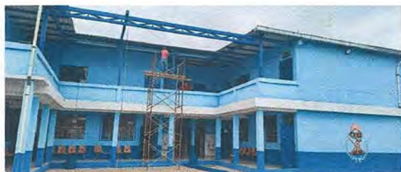
Foto 3: instalación de estructura para el techo
