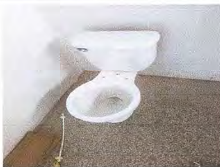
Foto 3: Iniciando a instalar sanitarios baños damas
