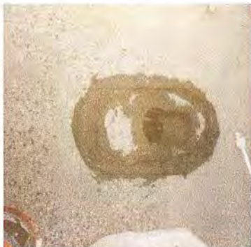
Foto1: Iniciando a instalar sanitarios baños damas
