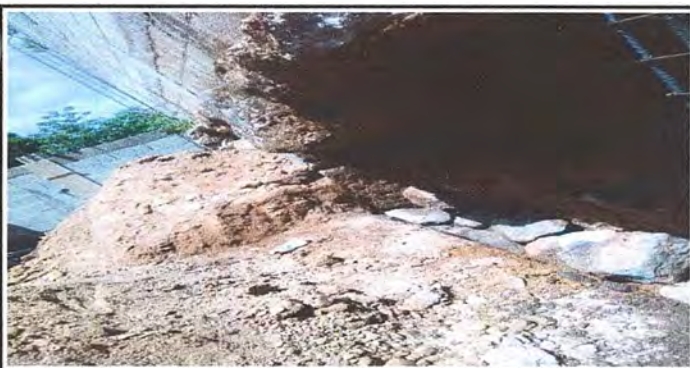
Foto 5: Iniciando la colocación de piedra
