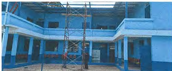
Foto 1: Iniciando trabajo de instalación de estructura para el techo
