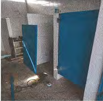
Foto 1: Instalando puertas de baños hombres segundo nivel
