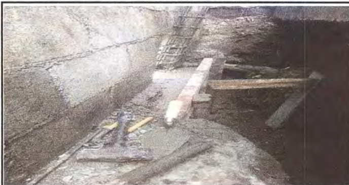
Foto 3: fundiendo cemento de piedra
