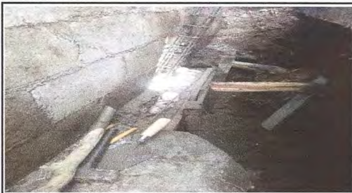
Foto 2: fundiendo cemento de piedra
