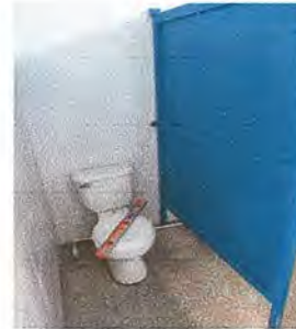
Foto 2: Instalando divisiones de baños damas segundo nivel
