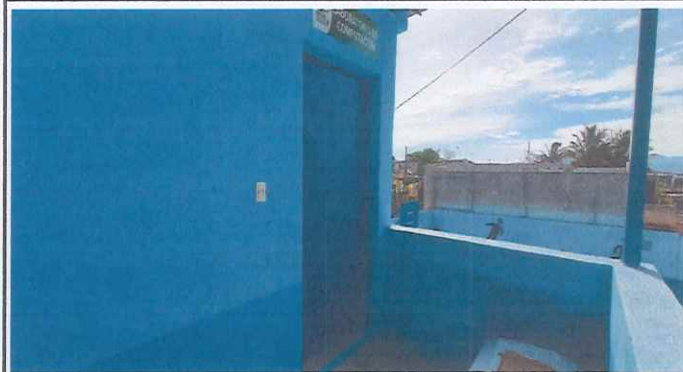
Foto 2: Área donde se instalará la puerta reja.
