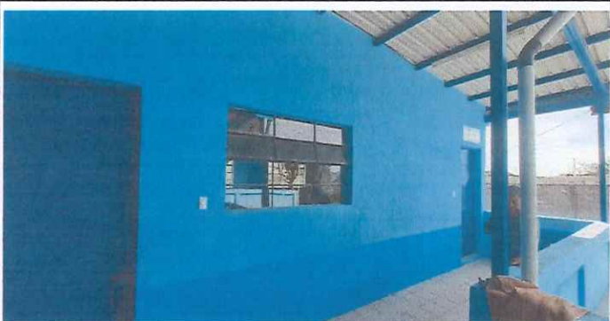
Foto 3: Vista completa donde se instalará el balcón y la puerta reja.
