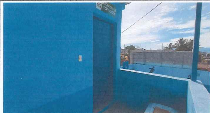
Foto 1: Se ve el área donde se colocará la puerta reja.
