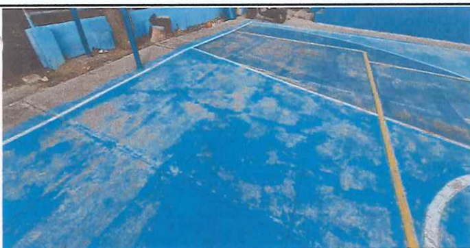
Foto 5: Demuestra el levantamiento de las planchas de concreto, para sustituir.
