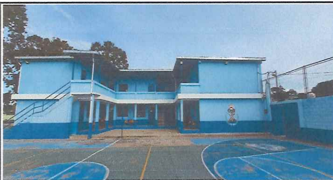
Foto 3: se observa el área a trabajar.
