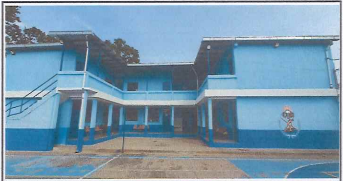
Foto 4: Observamos el área a instalar el techo.
