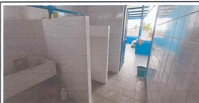
Foto 3: Servicios sanitarios a instalar la puerta respectiva.
