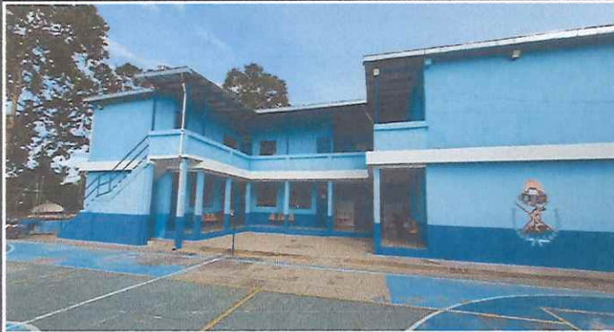
Foto 1: Área donde se colocará el techo.
