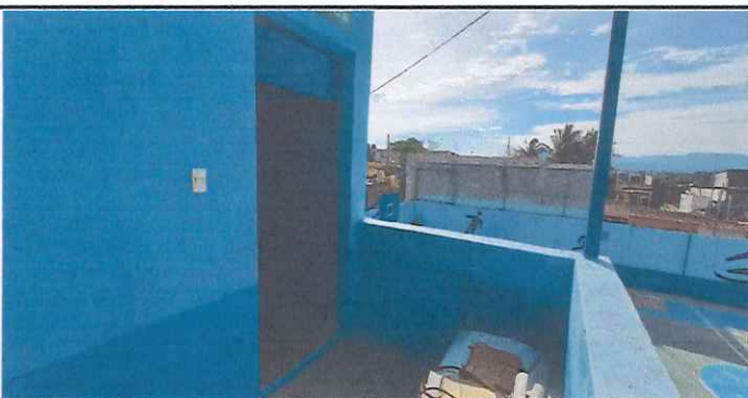
Foto 5: Vista individual de la puerta reja.
