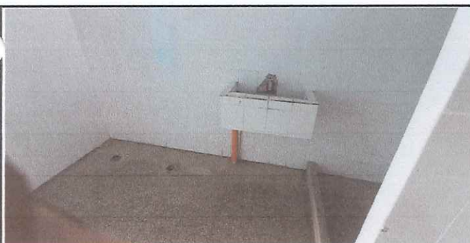
Foto 5: área donde se va a colocar las divisiones de metal y sus puertas.
