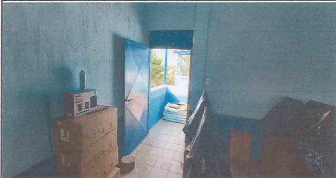
Foto 4: Vista interna donde se colocará la puerta reja.
