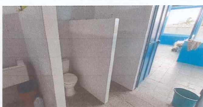
Foto 2. Servicios sanitarios de hombres a colocar las puertas.
