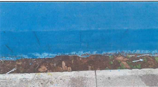
Foto 6: Hundimiento de la tierra donde se encuentra el muro parte interior de la escuela.
