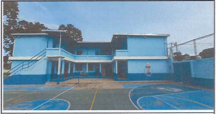
Foto 6: Área completa para instalar el techo.
