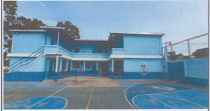
Foto 2: Observamos la parte frente donde se instalará el techo.
