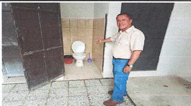
Foto3: Instalación de sanitarios nuevos
