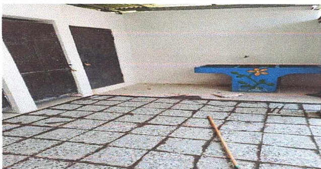
Foto1: Colocación de piso y nueva pila
