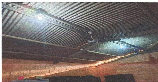
Foto2: Reparación sistema eléctrico de bodega
