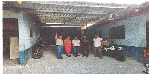
Foto5: Techado terminado portón de entrada
