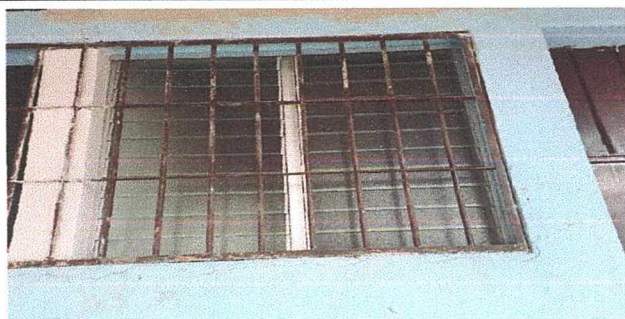
Foto5: Ventanales de cocina
