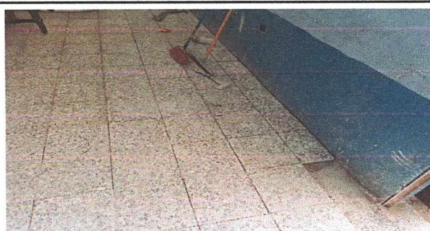
Foto6: Cambio de piso en aula
