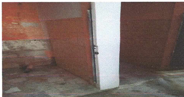
Foto2: Cambio de piso y sanitarios en baños
