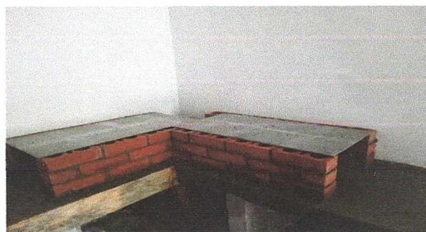
Foto4: Remodelación de cocina
