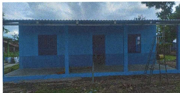
Foto 6: Remozamiento de aula.
