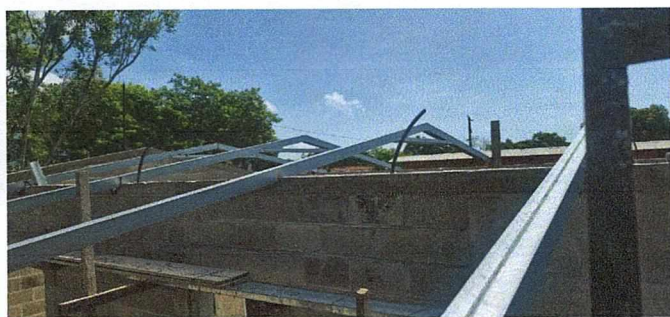
Foto 3: Remozamiento de aula.
