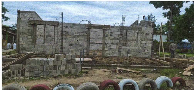
Foto1: Remozamiento de aula.
