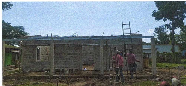
Foto 2: Remozamiento de aula.
