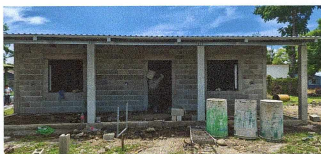
Foto 4: Remozamiento de aula.
