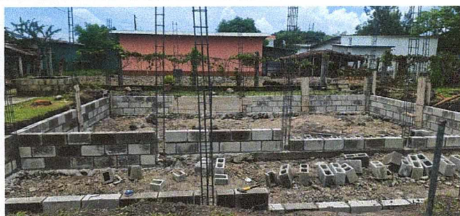
Foto 5: Remozamiento de aula.
