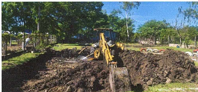
Foto 1: Remozamiento de aula.
