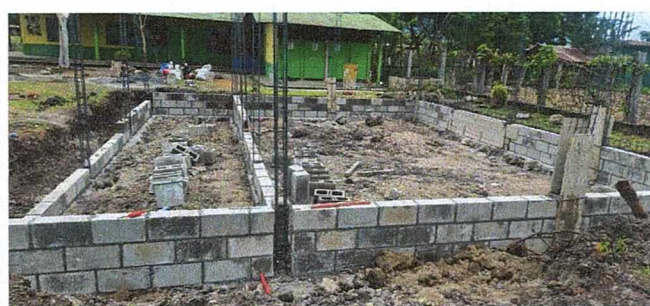
Foto 6: Remozamiento de aula.
