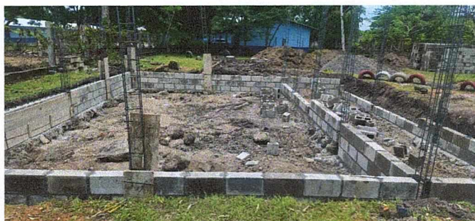
Foto 4: Remozamiento de aula.
