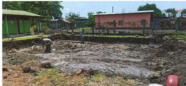
Foto 2: Remozamiento de aula.
