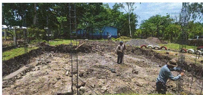
Foto 3: Remozamiento de aula.
