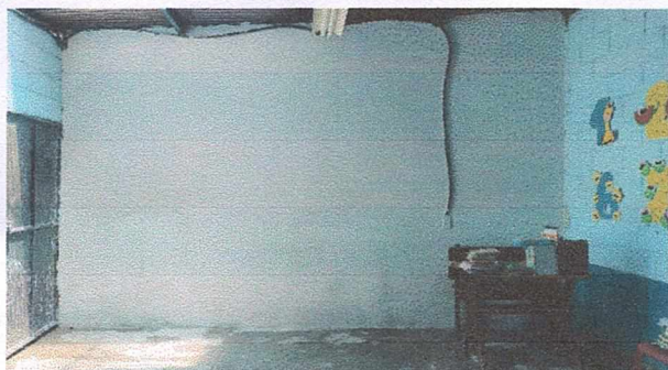
Foto 3: finalización de pared de aula
