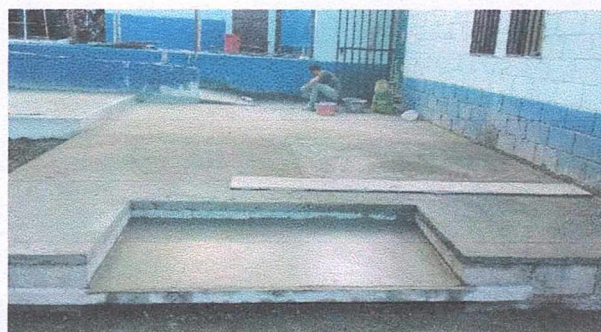
Foto 4: finalización de cemento en patio
