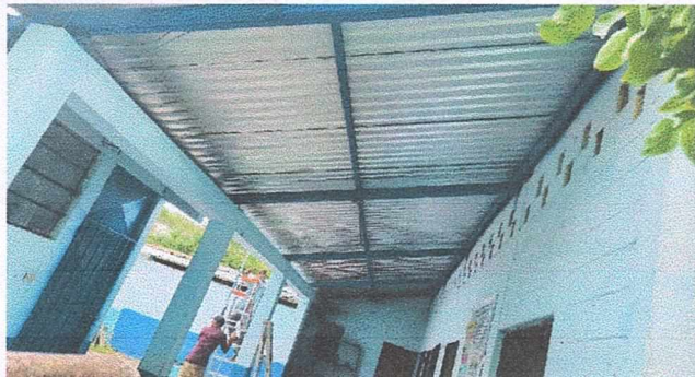
Foto 1: finalización de arreglo de techo
