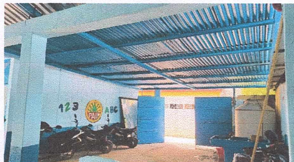
Foto 6: Finalización de techo frontal
