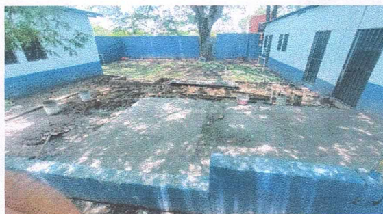
Foto 4: arreglo de piso de cemento en patio
