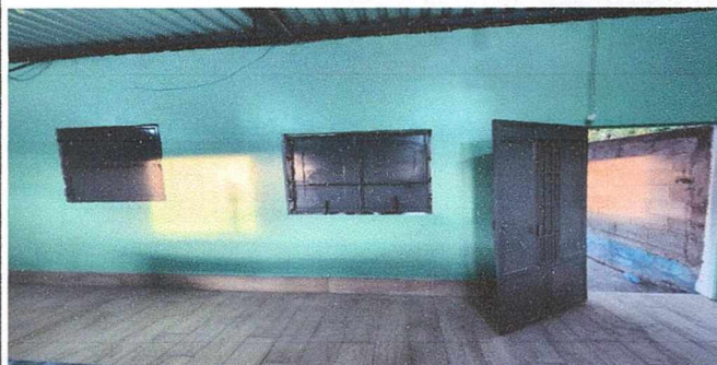
Instalación de ventanillas y reparación de puertas
