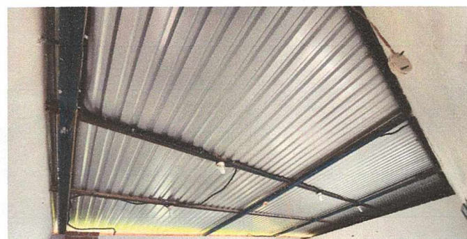
Instalación de lámina nueva
