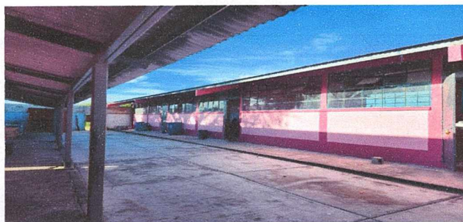
Pintura parte exterior de aulas
