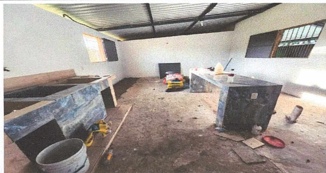
Construcción del área de cocina
