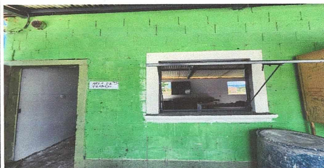
Reparación de ventanas
