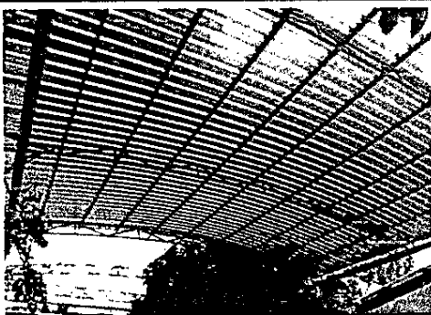
TECHO DE COMEDOR CURVO
