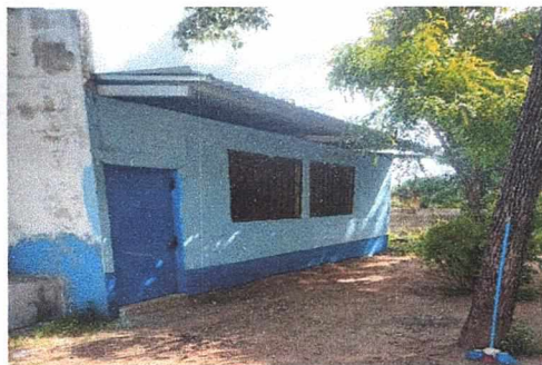
Foto 3. Techo de aula
