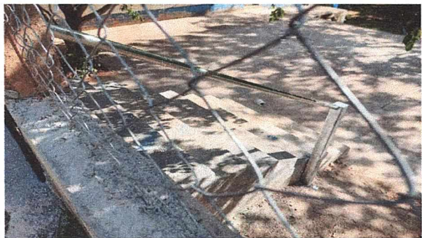
Foto 1. Muro reparado con malla nueva
