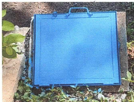
Foto 2. Tapadera de llave de paso de agua potable
