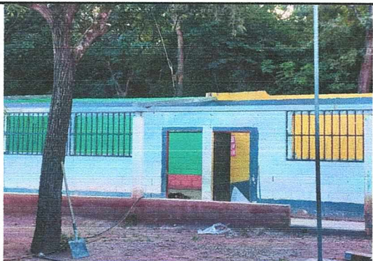
Foto 1. Desmontaje de Techo
