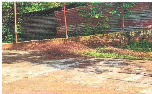
Foto 5. Desmonataje de malla
