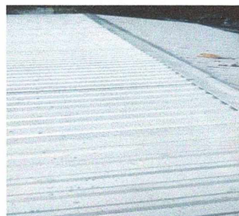
Foto 2: Mejoramiento de techo de aulas.
