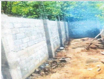
Foto 1: Mejoramiento de muro perimetral.
