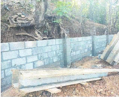
Foto 1: Mejoramiento de muro perimetral.
