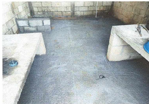
Foto 4: Mejoramiento y ampliación de polletón.
