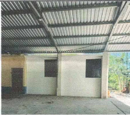
Foto 3: REPELLO DE LABORATORIO DE COMPUTACIÓN E INSTALACION DE VENTANAS
