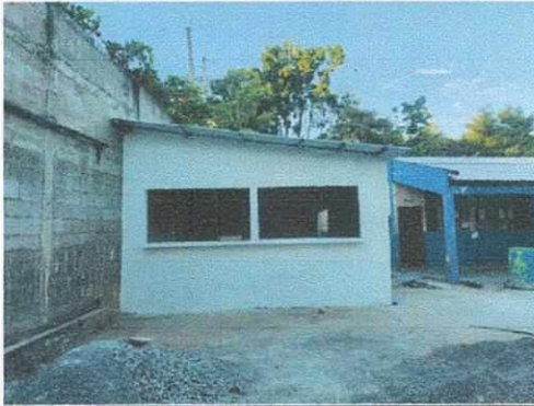
Foto 1: CONTINUACION DE PARED DE BLOCK Y COLUMNAS PARA COCINA
