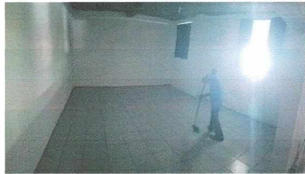
FOTO 4: CONTINUACION DE REPELLO Y CERNIDO EN INTERIOR DE AULA DE COMPUTACION
