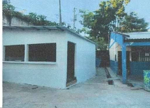
Foto 2: CONTINUACION DE TECHO PARA COCINA
