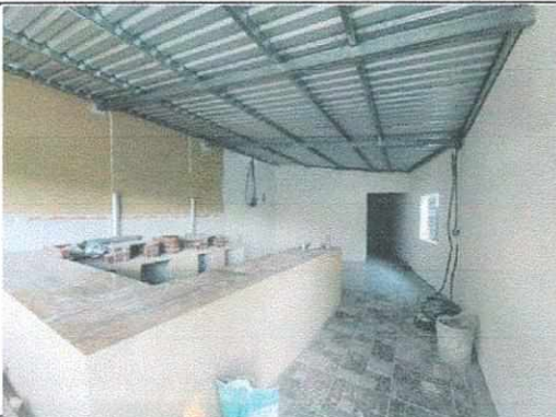
FOTO 5: Ampliación de la cocina
