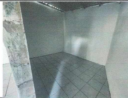
FOTO 6: Bodega para cocina
