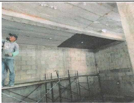
Foto 4: CONTINUACION DE REPELLO Y CERNIDO EN INTERIOR DE AULA DE COMPUTACION
