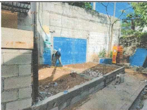
FOTO 5: Ampliación de la cocina
