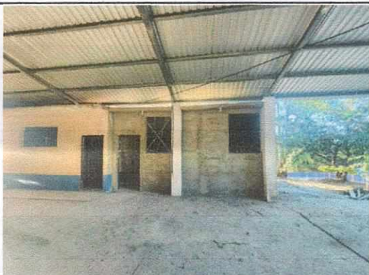
Foto 3: REPELLO DE AULA DE COMPUTACION E INSTALACION DE VENTANAS
