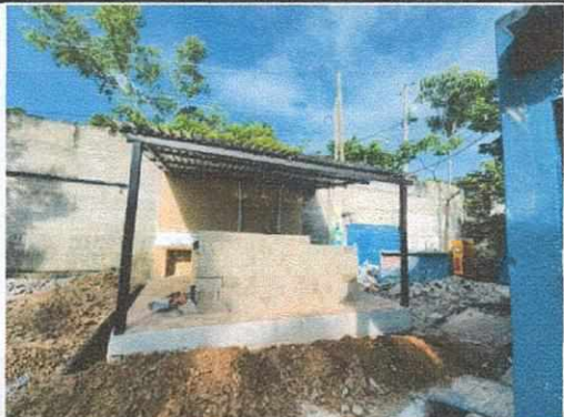
Foto 1: CONTINUACION DE PARED DE BLOCK Y COLUMNAS PARA COCINA
