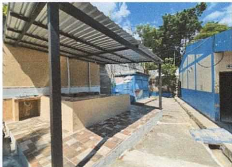
Foto 1: CONTINUACION DE PARED DE BLOCK Y COLUMNAS PARA COCINA
