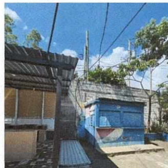
Foto 2: CONTINUACION DE TECHO PARA COCINA
