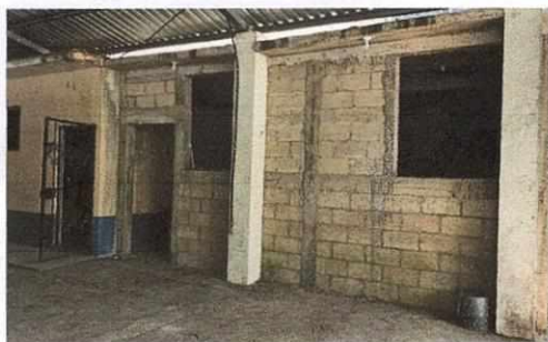
Foto 3: REPELLO DE AULA DE COMPUTACION E INSTALACION DE VENTANAS
