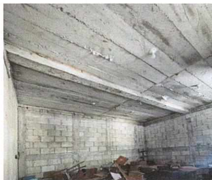
FOTO 4: CONTINUACION DE REPELLO Y CERNIDO EN INTERIOR DE AULA DE COMPUTACION
