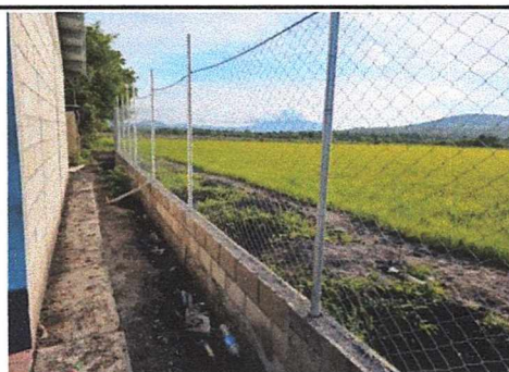
Foto 6: Reparación de muro perimetral de block con tubo hg y malla galvanizada, soleras intermedias y columnas
