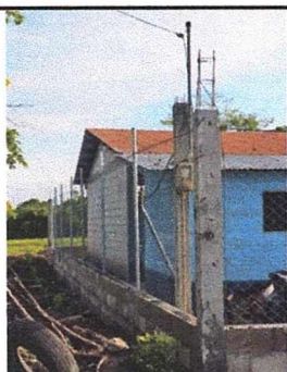
Foto 5: Reparación de muro perimetral de block con tubo hg y malla galvanizada, soleras intermedias y columnas
