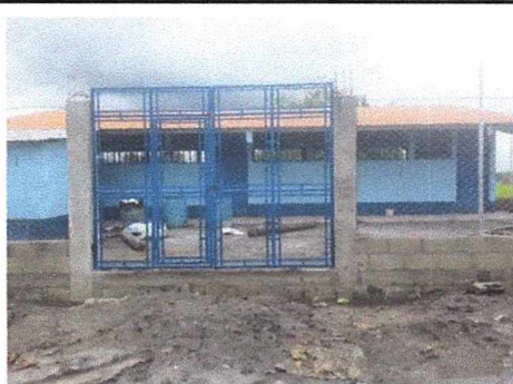
Foto 1: Mejoramiento de portón de acceso
