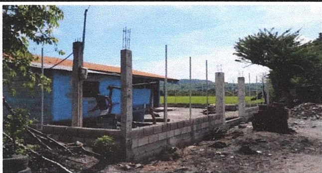
Foto 3: Pintura en muros interiores y exteriores
