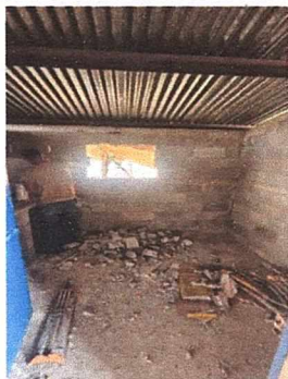
Foto 1: Reparación de estufa rural y mejoramiento en area de cocina.
