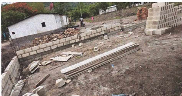
Foto 5: Reparación de muro perimetral de block con tubo hg y malla galvanizada, soleras intermedias y columnas
