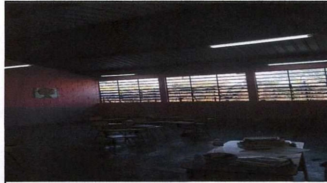
Foto 2: instalacion de los nuevos Tubos Led y funcionado
