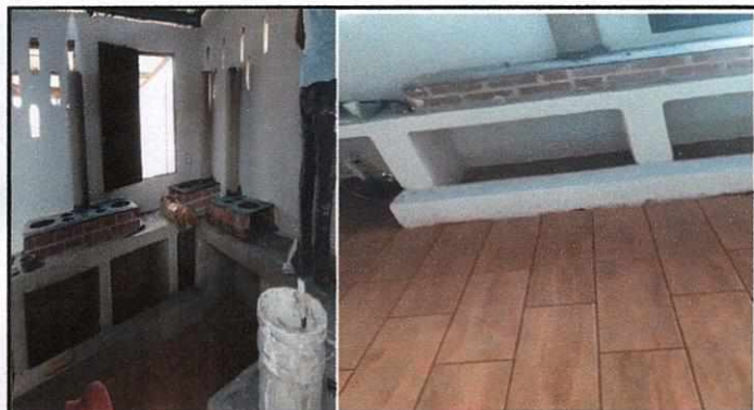
Foto 3: imagen de colocacion de planchas y repeyo y piso
