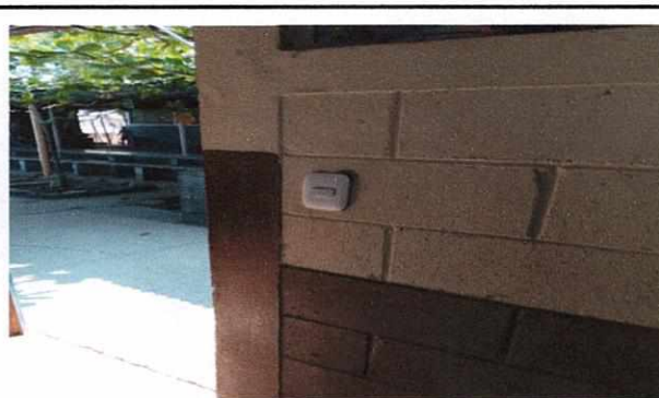
Foto 4: instalacion de nuevos apagadores en las diferentes aulas
