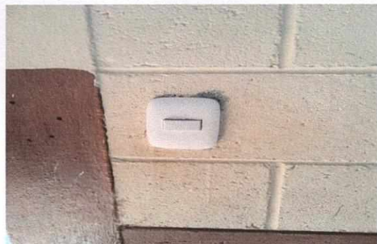
Foto 5: instalacion de apagadores
