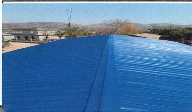
Foto1: finalizacion de Pintura de techo de dos modulos
