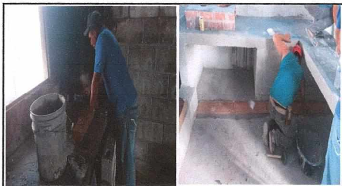
Foto 4: Instalando los ladrillos para instalar las planchas en la cocina, y colocando piso.
