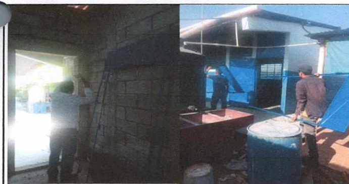
Foto 5: Herreros instalando las puertas en las dos aulas
