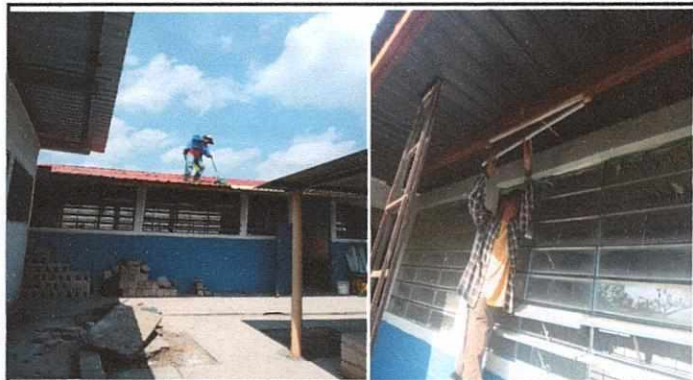
Foto 2: Limpiando la lamina para pintarla, y quitando las candelas para instalar los nuevos tubos led.
