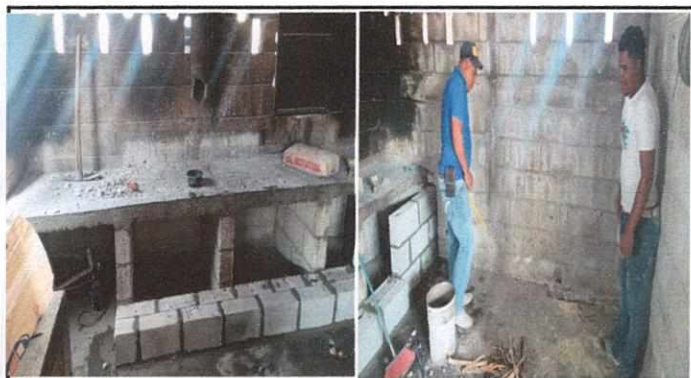
Foto 3: Albañiles trabajando en la cocina
